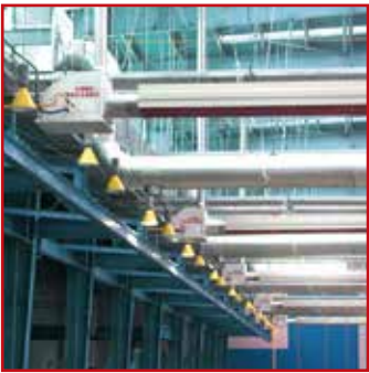
Installation au plafond Plafondmontage
