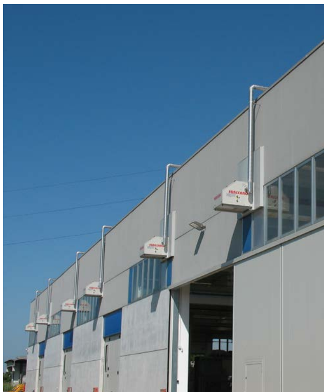
Exemples d'installation suspendue au mur
