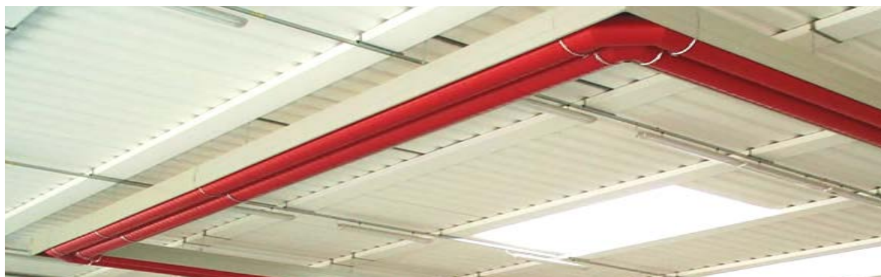
Modules Girad assemblés et installés
