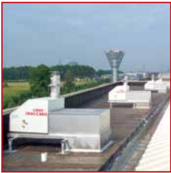
Installation en toiture Dakmontage
