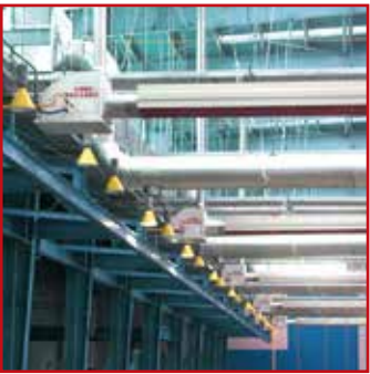
Installation au plafond Plafondmontage
