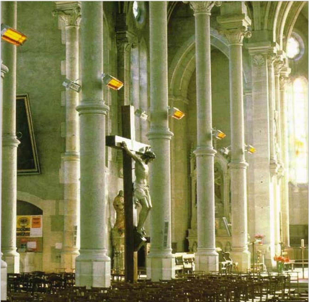
Le chauffage céramique a été conçu et mis au point pour son application dans les bâtiments de 5m de hauteur et plus. Les appareils utilisés sont des radiants céramiques à rayonnement "longue portée".
