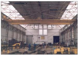
Les appareils ont été placés à 14 m de haut, libérant ainsi tout le volume nécessaire au déplacement du pont roulant existant. Au départ, nous avons craint que la technique et le faible nombre de radiants ne suffisent pas.
