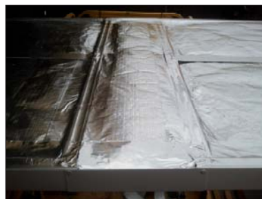
5. Poser l'isolant supérieur avec feuille d'aluminium
