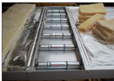
2. Poser le capot intermédiaire et le riveter
