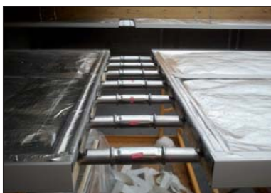
1. Emboîter les tubes et les presser avec un bec M28
