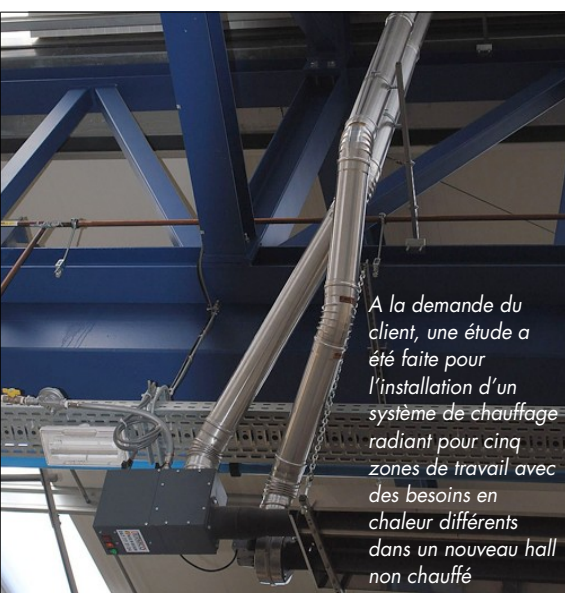
L'installation des tubes radiants sombres dans l'atelier d'entretien de Willy Naessens
